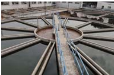
沈殿池(手前)と濾過池(左奥)
