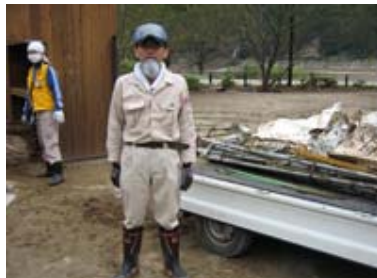
熊野川の氾濫で土砂に埋まった公共施設での泥出し・備品搬出ボランティア
