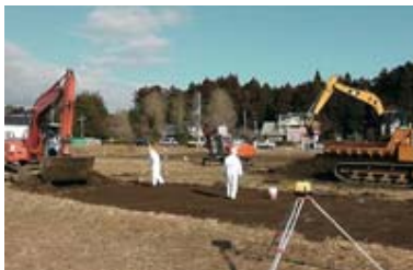
バックホウなどの重機を使って田畑の表層をはぎ取る作業。
