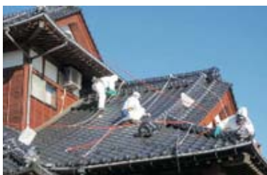
屋根の除染作業。特殊な紙タオルを使って拭き取ります。
