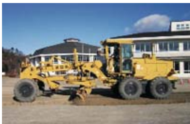
大型機械による小学校グラウンドのすき取り作業。
