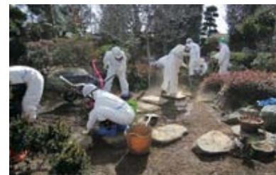
手作業による、民家の庭土のすき取り。
