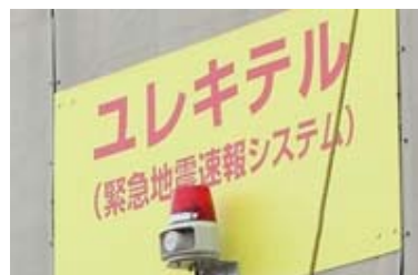
作業所設置の様子
