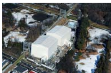
大型ビームテント設置状況
