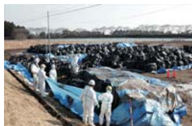
除染作業で出た汚染廃棄物をビニールシートで覆う作業。廃棄物はその後仮置き場に移されます。
