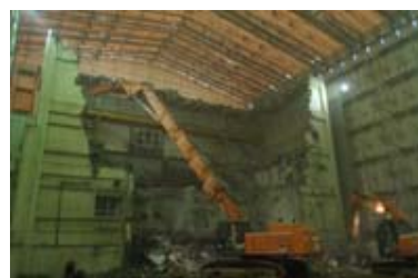
施設解体状況
