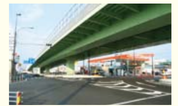
国道2号岡山市内立体高架橋
