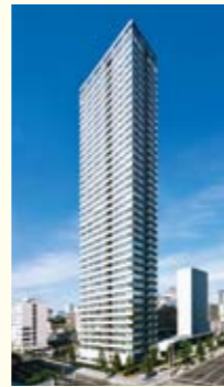
札幌大通東2丁目計画新築工事
