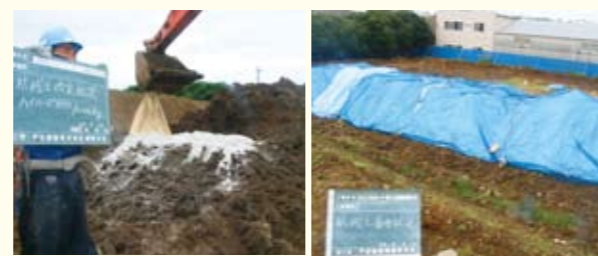
改良材を混合 改良処理後にシート養生
