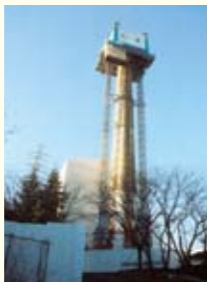
チムリス煙突解体システム
