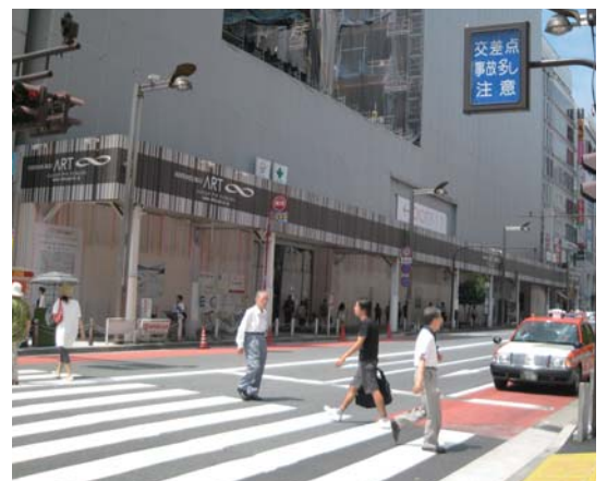
工事の様子と仮囲い
