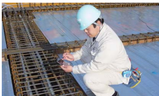
作業所検査(配筋検査)の様子
