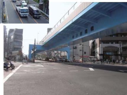
工事後のとつみ橋交差点
