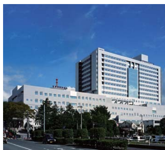
発注者 (学)東海大学 設計 戸田建設(株) 施工 戸田建設(株)、他1社JV
