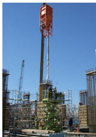
超高強度コンクリートの打設状況(1階柱)
