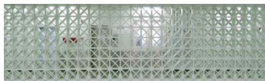
UFCブロック耐震壁の施工例
