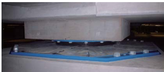
弾性すべり支承設置状況
