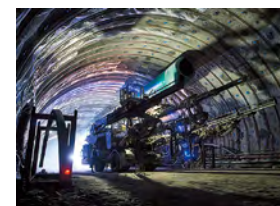
トンネル穿孔機械(ドリルジャンボ)
