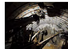
鏡ボルト打設状況
