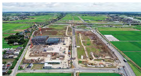
新たな拠点創出向け造成工事・建築工事が進む施工の様子
