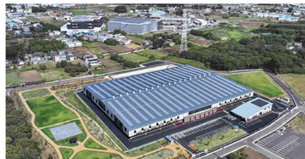
所沢市第2一般廃棄物最終処分場
