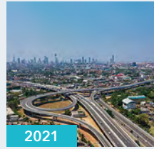
2021 ケラニ河新橋建設工事
