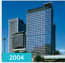
2004 丸の内オアゾ 丸の内北口ビルディング
