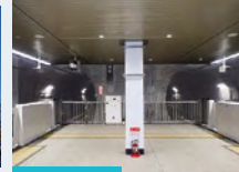
2023 相鉄・東急直通線 綱島トンネル
