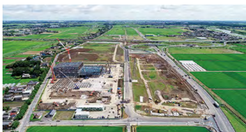
新たな拠点創出へ向け造成工事・建築工事が進む施工中の様子
