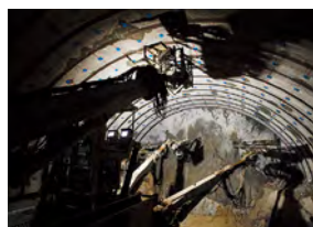
鏡ボルト打設状況
