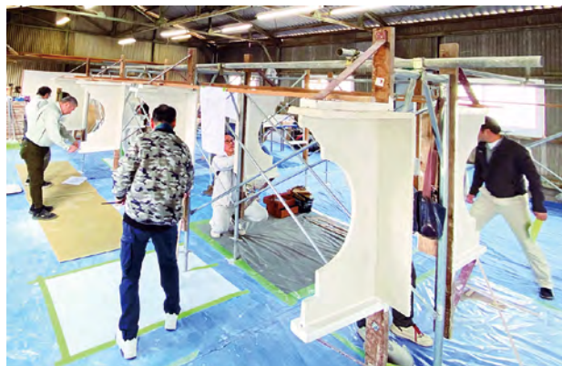
1・2級左官技能検定のための講習会実施風景
