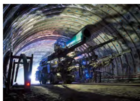
トンネル穿孔機械(ドリルジャンボ)
