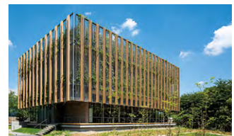
グリーンオフィス棟(2021年5月竣工)
