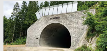
道路橋りょう整備(再復)工事(トンネル) [(仮称)博士トンネル]
