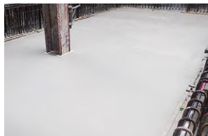
TODA BUILDING 耐圧スラブのスラグリート®70適用状況
