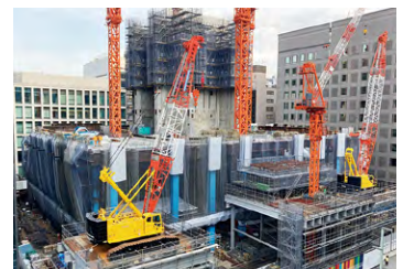
新本社ビル建替え工事の施工状況 (2023年6月30日)
