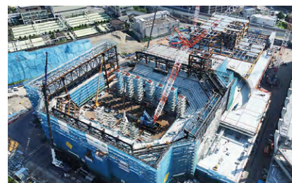
大型アリーナ施設の鉄骨工事の様子
