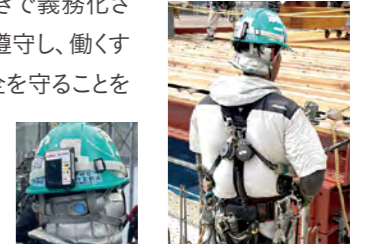
ヘルメット型安全管理システム 作業所での熱中症対策 (ファン付き作業服)
