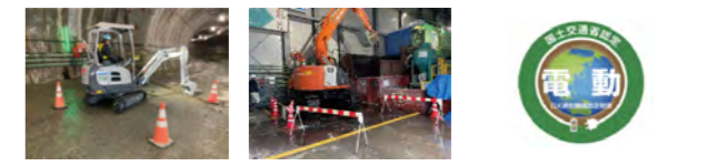
坑口での路盤維持作業 シールド立坑での掘削作業 GX建設機械の認定ラベル
