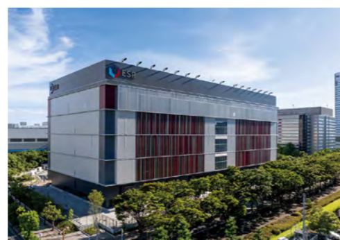
ESR南港 OS1 データセンター
