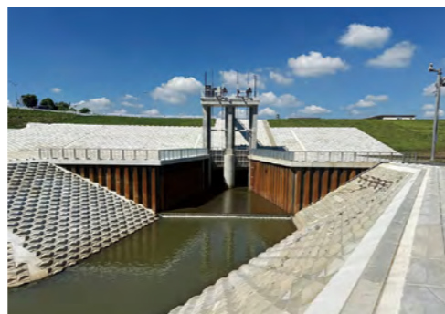
関東地整入間川古谷橋管改築工事
