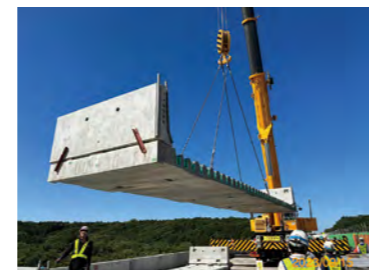
床版と壁高欄の一体架設
