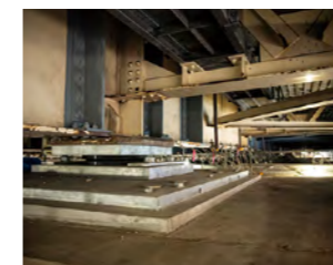
新設支承設置状況
