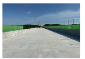
床版取替工事後のママチ川橋
