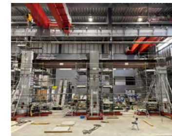
PCaラーメン構造の実大施工実験
