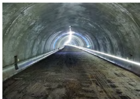
窪川佐賀道路平串トンネル
