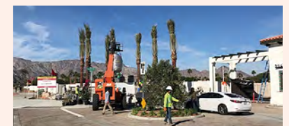
植栽工事施工の様子
