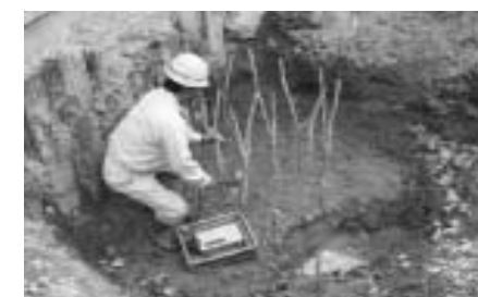
既存杭の調査状況
