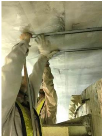
写真-6 センサ貼付け状況
