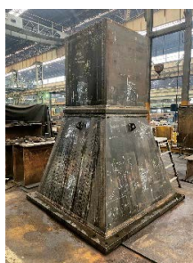
写真 1 0節柱製作状況
