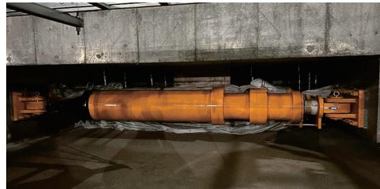
写真 自己復元型トリガー機構付きオイルダンパー
