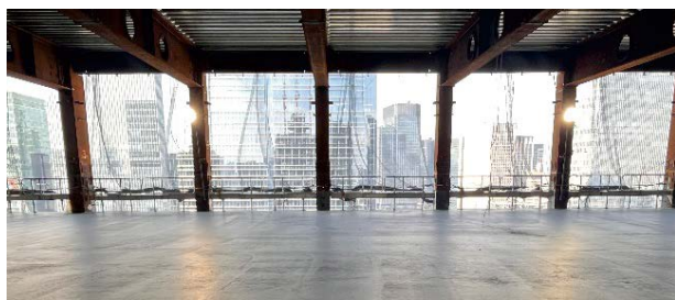
図13 基準階の外周細柱架構
