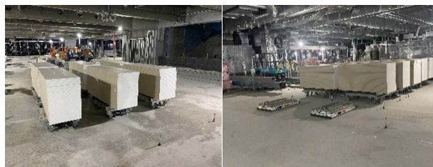
写真5 17階ストックヤード 状況
