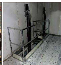
ガイドレール施工時
