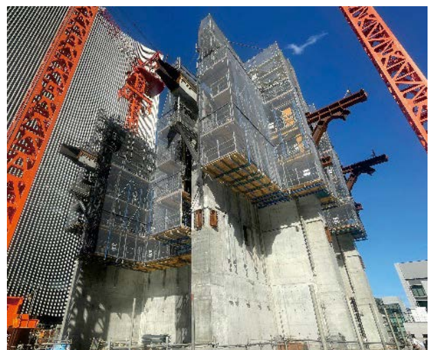
写真 1 コアウォール部およびクライミング型枠
