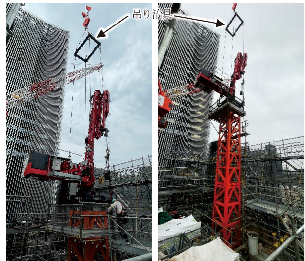
写真9 ディストリビューターのクライミング状況
