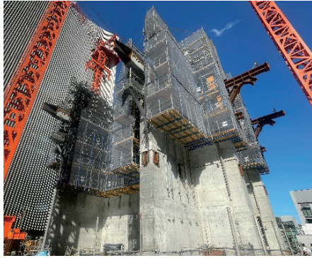
コアウォールおよびクライミング型枠
