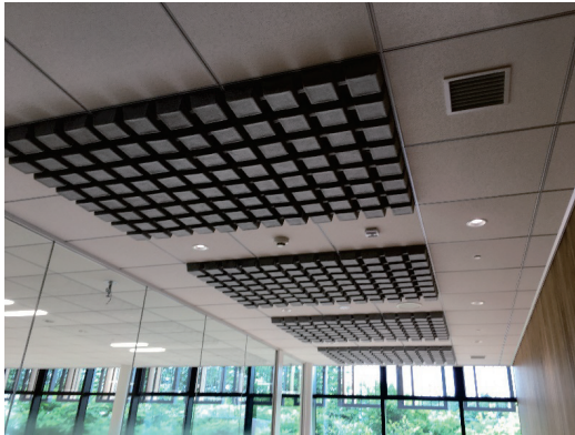
グリーンオフィス棟設置状況
