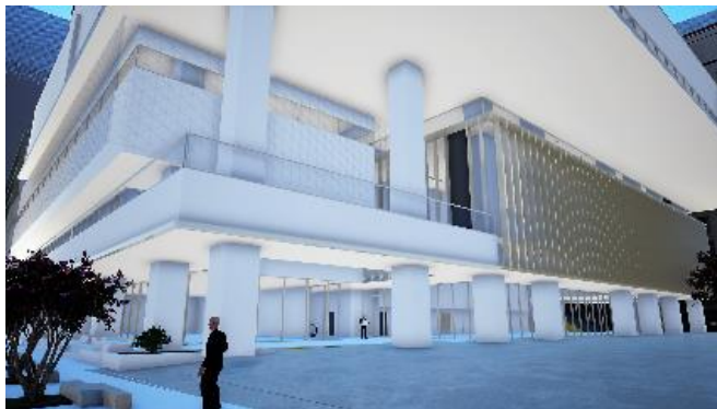
図10 エントランスアプローチ外観
