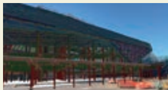
MR上で鉄骨外観の出来形を検証
