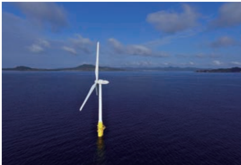
現在、長崎県五島市沖に稼働している洋上風力発電設備（撮影：西山芳一）
