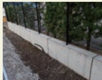
写真3 自己治癒コンクリート適用状況(擁壁部)
