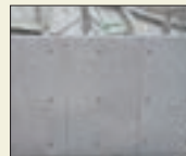
写真3 無機系短繊維補強 コンクリートの仕上がり
