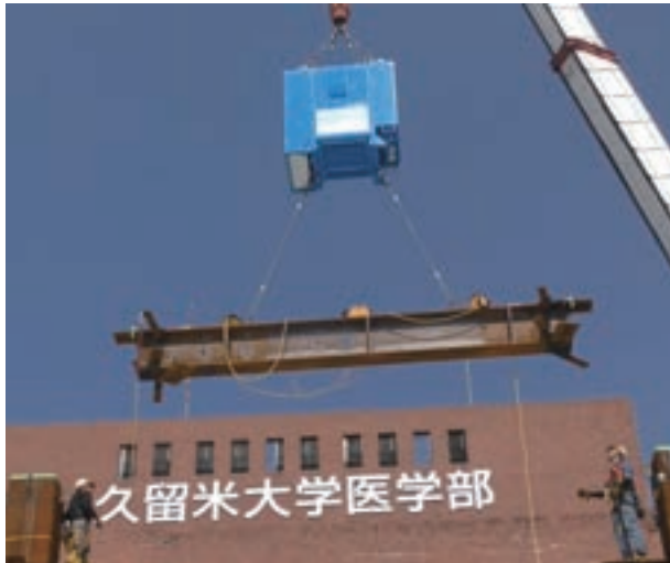
吊荷旋回制御装置「ジャイアン®」適用状況
