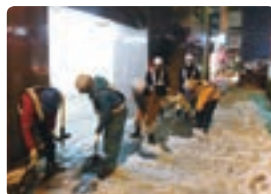
除雪作業の様子
