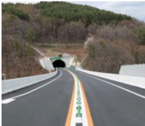
中部横断自動車道舗装12工事
