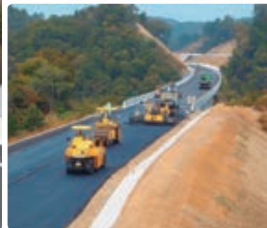
尾道・松江自動車道 宇賀舗装工事
