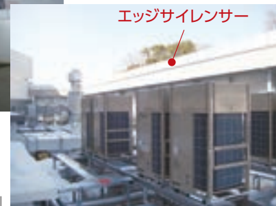
屋外設備機器置場への適用例
