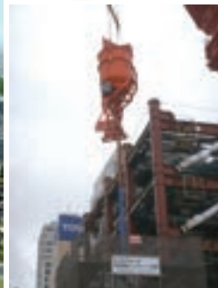
柱打込み状況
