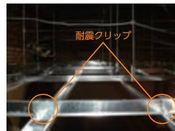
耐震クリップ取り付け状況
