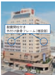
弁天プラザビル （補強工事完成後・建物外観）
