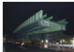
国道2号岡山市内 立体高架橋の施工状況
