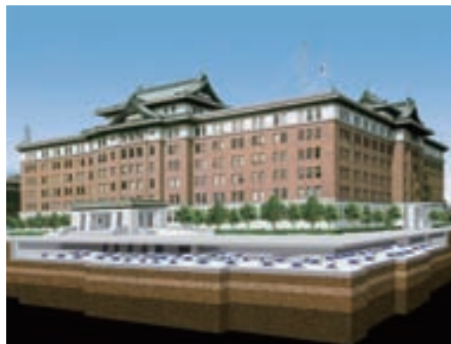
愛知県庁本庁舎の建物全景と地下の免震層
