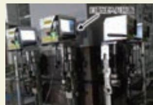
写真7 鉄骨柱の自動計測・建入れ調整システム
