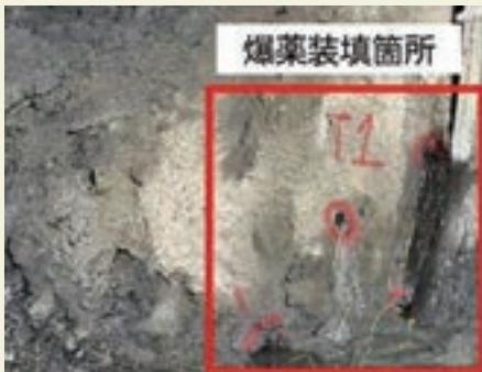
写真2 爆薬装填完了
