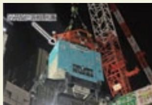
写真3 吊荷旋回制御装置
