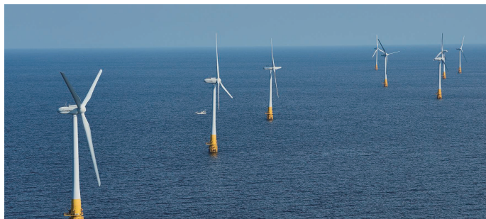
風車8基の全景
