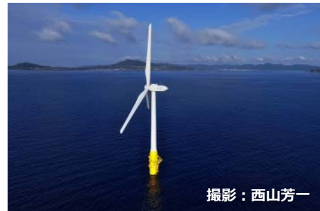
浮体式洋上風力発電
