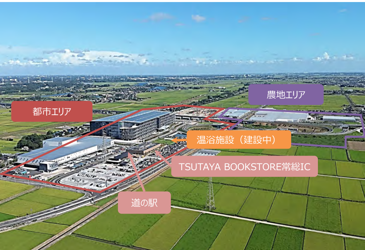
常総プロジェクト エリア全景
